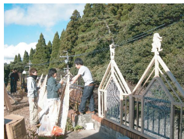
写真1 枠の設置作業
