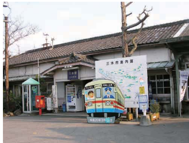
写真1 原形保存地区A（旧三木駅）現況
